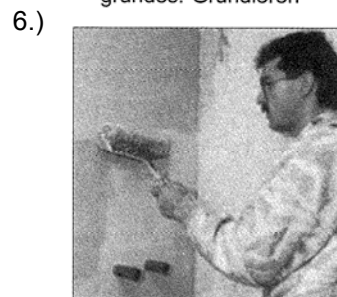
Schutzschicht aufrollen....
