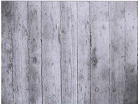
Schalungstyp 3 Sichtbetonfläche mit Brettstruktur
