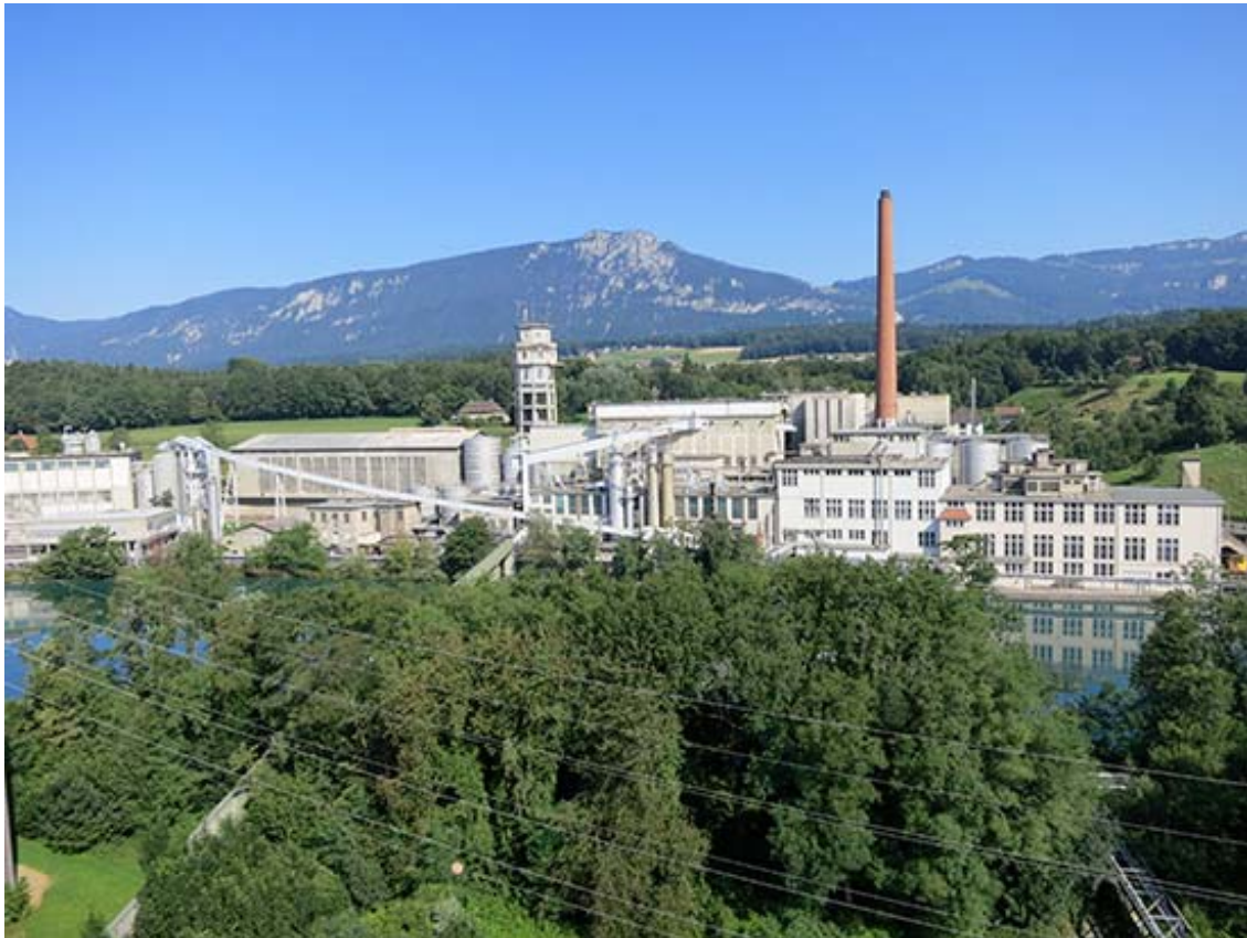
Das Attisholz-Areal liegt attraktiv an einem Südhang, der direkt an die Aare grenzt. (Foto Metron) (Quelle: attisholz-infra.ch)
